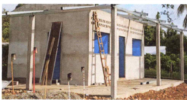
Foto 5: sustitucion de puerta de madera por metal
