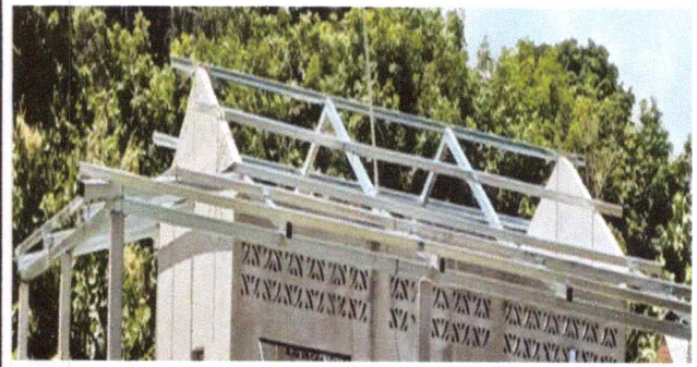
Foto 4: sustitucion de soporte de madera por metal
