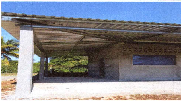
Foto1: sustitucion de lamina, por lamina troquelada alizinc calibre 26 de 12 pies.
