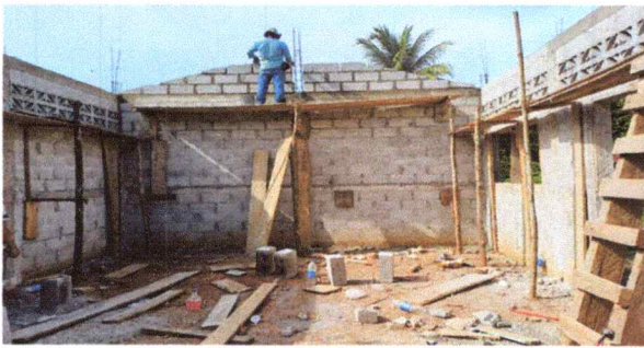
Foto 3: sustitucion de piso de torta de cemento
