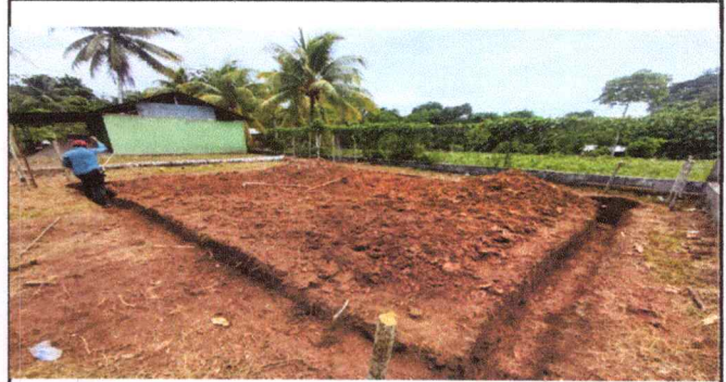
Foto 2: Reparacion de cuneta de concreto
